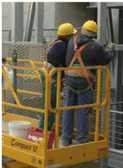
Le costruzioni tra i settori più dinamici
